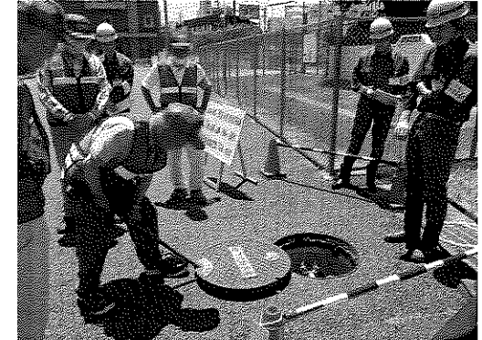
【防災訓練(地下式給水栓の操作)】
