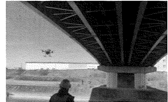
【ドローンによる水管橋の点検】
