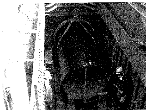
朝日系導水路B管の更新
