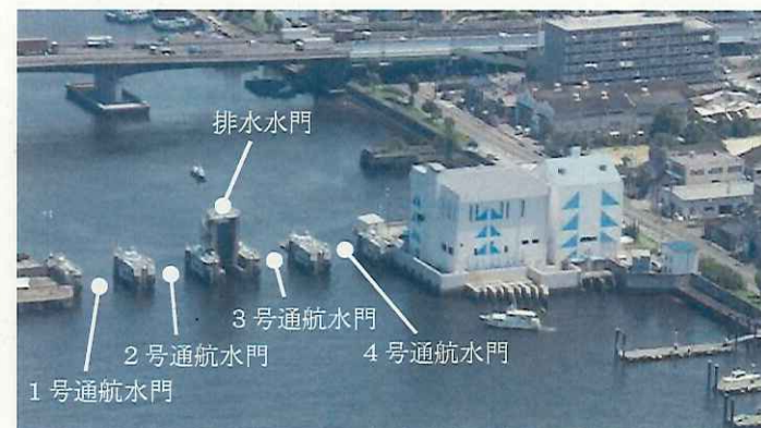
【 堀川口防潮水門 】
