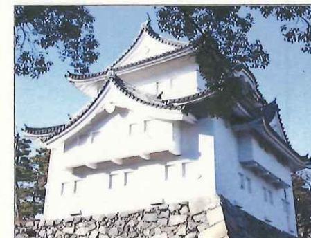
東南隅櫓（重要文化財）
