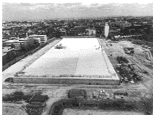
東山配水場3・4号配水池の工事
