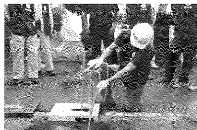
仮設給水栓の設置訓練
