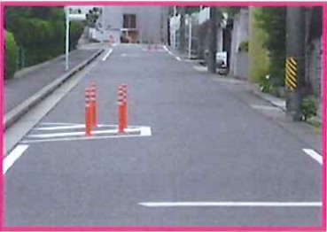
● 狭さく設置 — 防護柵設置
