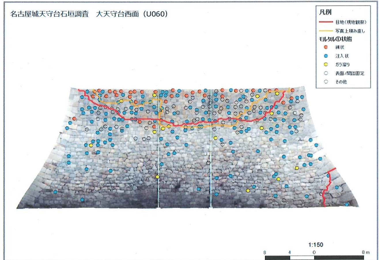
図20 U60モルタル検出状況
