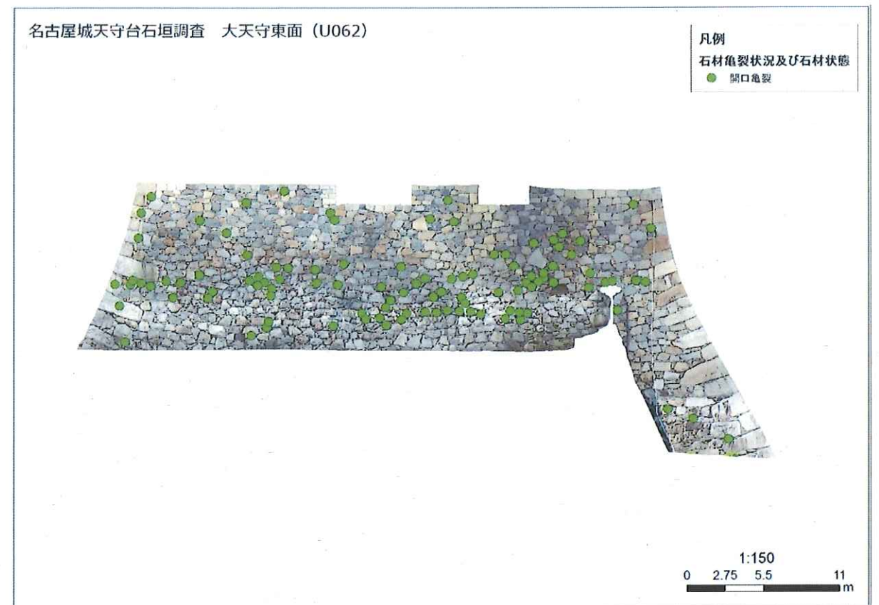
図26 U62石材劣化状況
