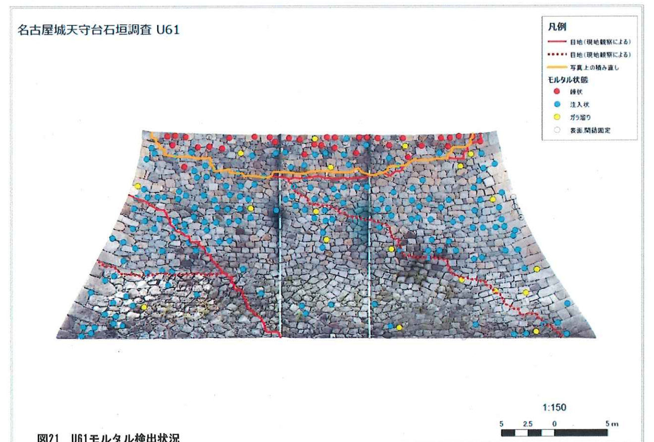
図21 U61モルタル検出状況
