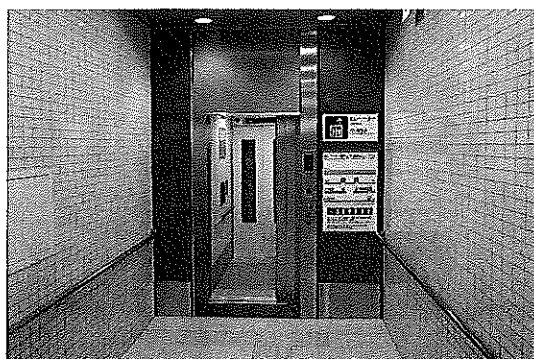
桜通線丸の内駅改札内乗換エレベーター
