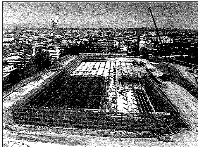
【東山配水場 3・4 号配水池】
