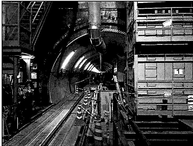
【名古屋中央雨水調整池(工事中)】
