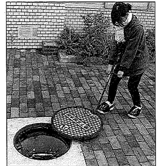
【地下式給水栓の操作の様子】
