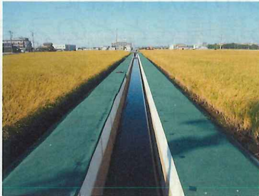
水路の寿命を延ばす補修（港区）
