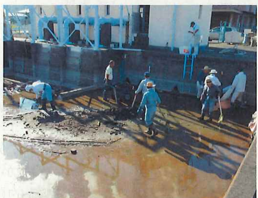
排水機場のしゅんせつ作業（港区）
