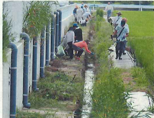
水路の草刈り作業（港区）
