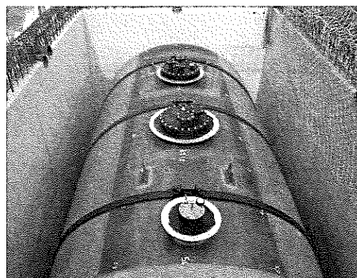
鍋屋上野浄水場燃料貯蔵槽の増強
