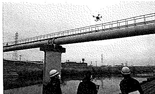
ドローンを活用した水管橋の点検
