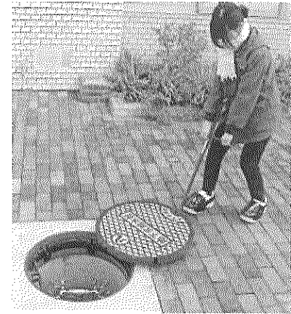
【地下式給水栓の操作】
