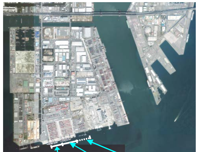
飛島ふ頭南側 第1バース・第2バースと第3バース予定地
