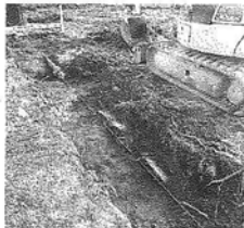
掘削により破壊した名古屋城西之丸エリアの地下遺構＝名古屋市提供
