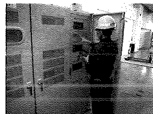
電気設備の点検
