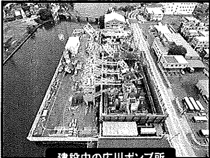
建設中の広川ポンプ所
