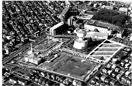
写真：鳴海配水場3号池配水池の工事
