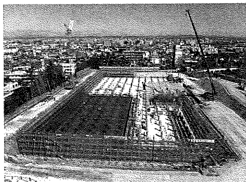
写真：東山配水場3・4号配水池の工事
