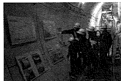
写真：工事現場見学会
