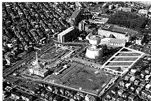
写真：鳴海配水場3号池配水池の工事
