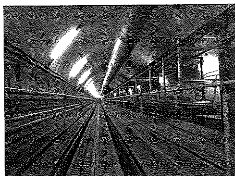
写真：雨水調整池の建設現場 ／名古屋中央雨水調整池（工事中）
