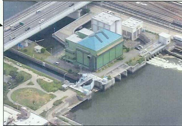
中川口通船門耐震補強
