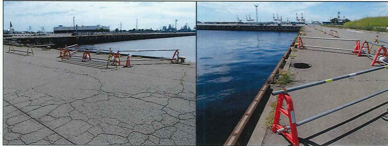
金城ふ頭物揚場補修工事
