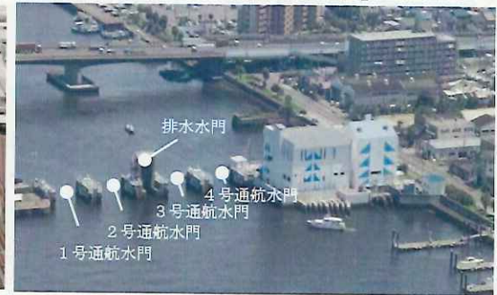
【② 堀川口防潮水門】
