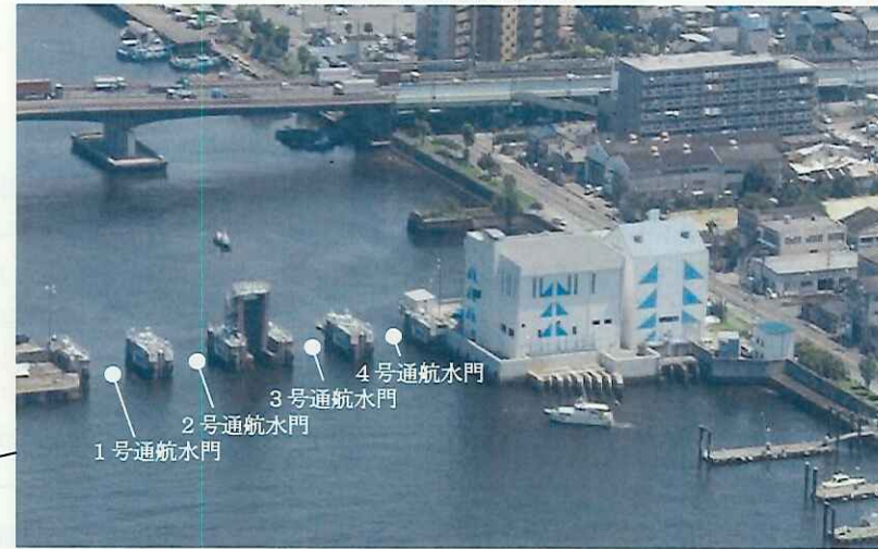
【 堀川口防潮水門 】
