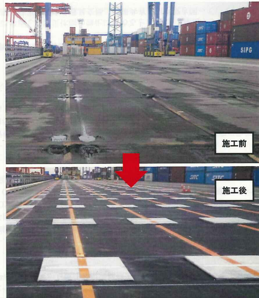
【 コンテナヤードの舗装改良 】
