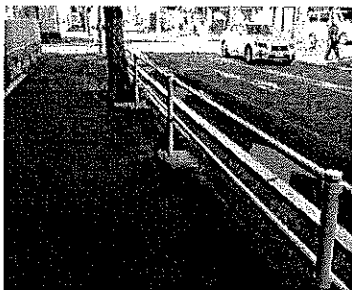
狭い歩道にガードパイプを設置
