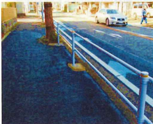
狭い歩道にガードパイプを設置
