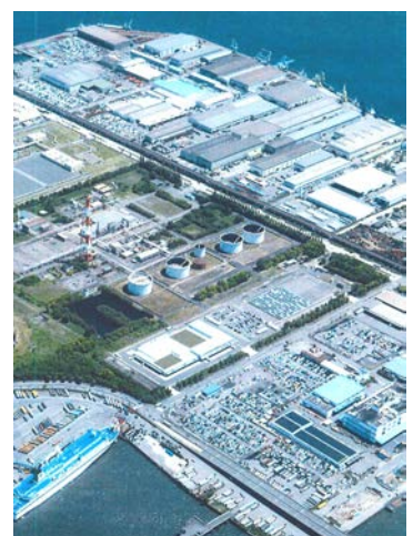
空見ふ頭の 浮き屋根式大型タンク
