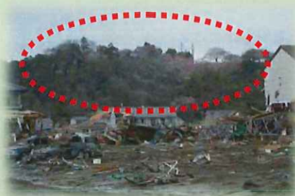
出典：東日本大震災における公園緑地等現地概査（公園緑地協会，2011） 津波の被害を免れた日和山公園（石巻市）
