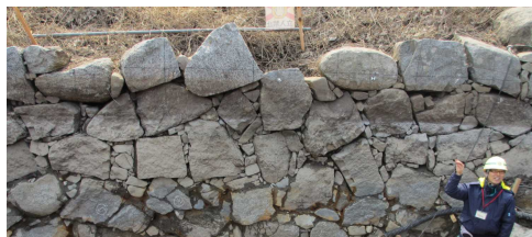
修復中の 石垣
