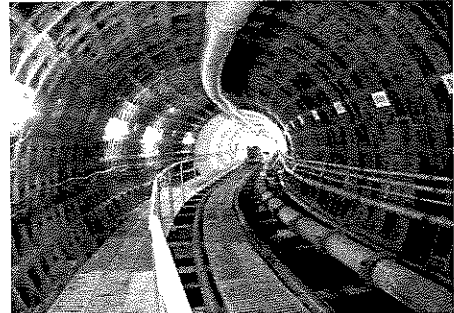
写真：雨水調整池の建設現場 ／中村中部雨水調整池（工事中）
