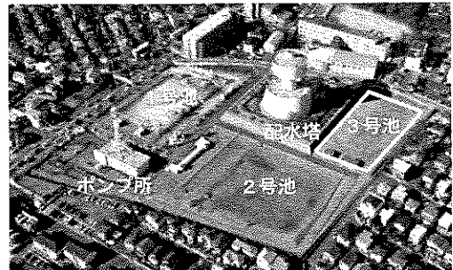
写真：鳴海配水場3号配水池の工事
