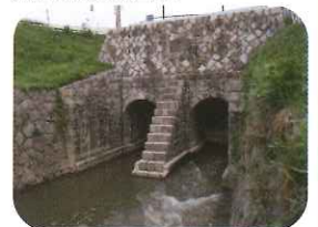
庄内用水元杵樋
