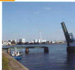
名古屋港跳上橋
