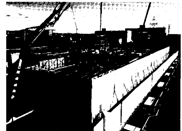
【春日井浄水場新送水ポンプ所】
