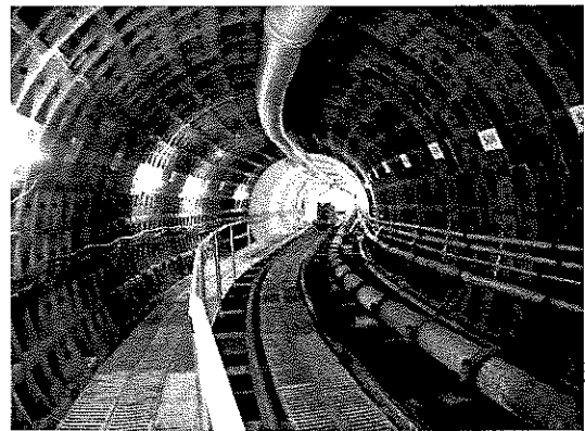
写真：雨水調整池の建設現場 ／中村中部雨水調整池（工事中）
