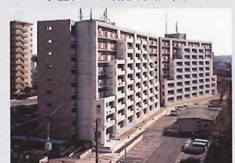
市営住宅の耐震改修事例
