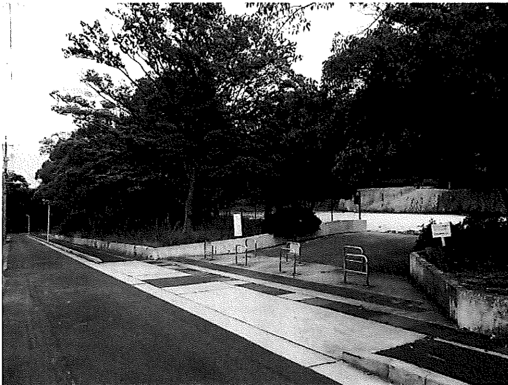
(2) 広場北側の歩道
