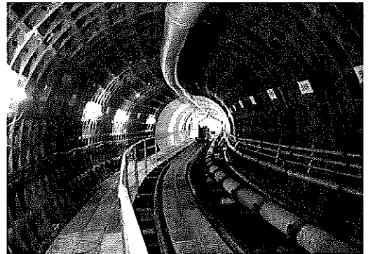
建設中の中村中部雨水調整池の内部
