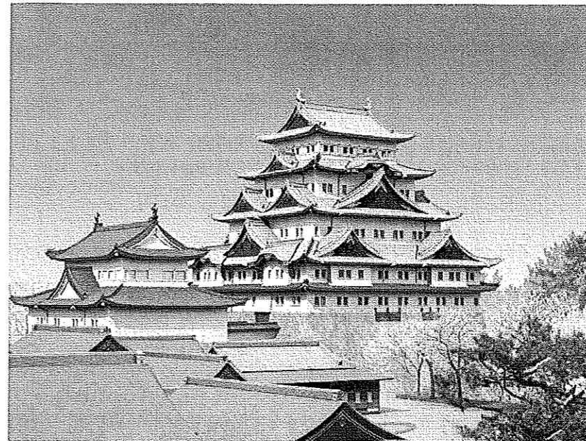
東南側から本丸御殿の屋根越しの外観
