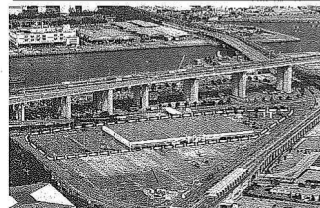
金城ふ頭に建設される立体駐車場の予定地（点線）。手前右はあおなみ線の金城ふ頭駅＝名古屋市港区で、本社へ「まなづる」から
