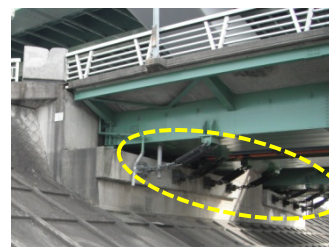
橋りょうの耐震補強の例
