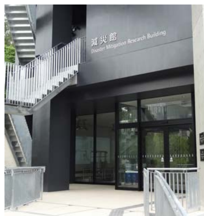
減災館の玄関。建物が三角形なのは、そんな土地しか与えられなかったとか。
