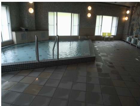
大浴場の水漏れで 1 か月の休館になったが、昨年末に改修しオープン。
