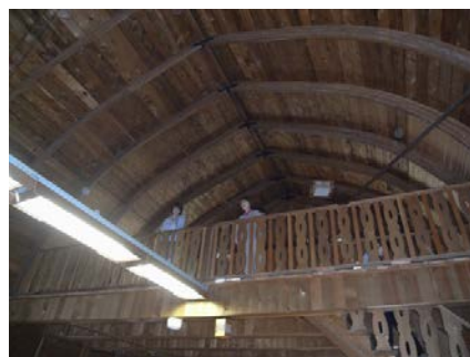
修繕した大型キャビン。
