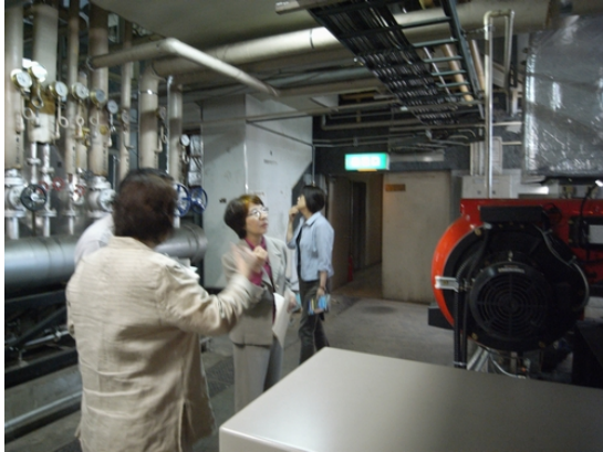
開設当時のボイラーをいまだに使っています。
