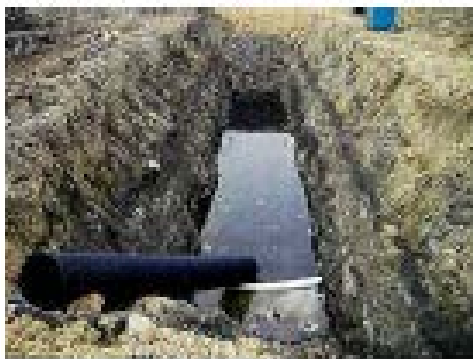
暗渠埋設工事中
