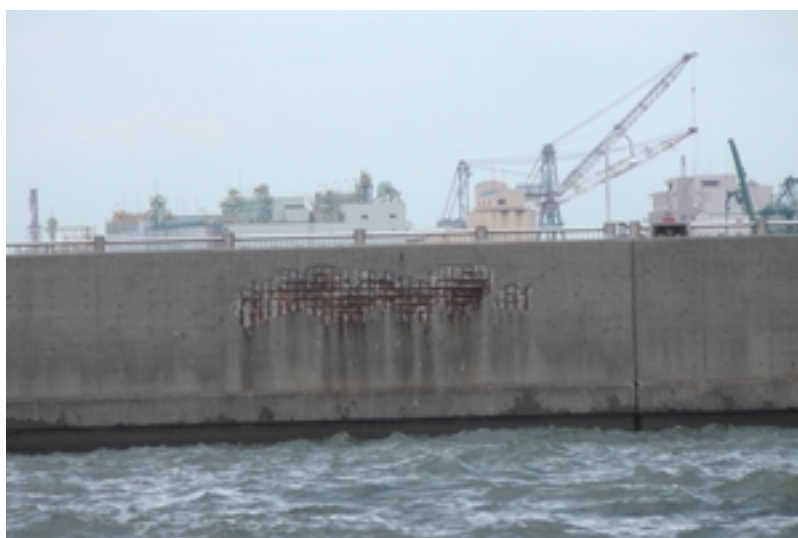
図 10 知多堤の浮き出た鉄筋
