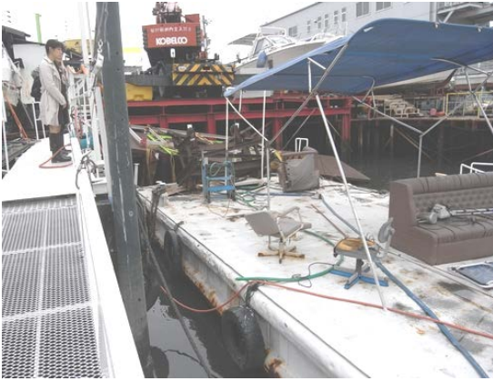
右の桟橋が底部損傷で水没。岸に寄せてある。本来はタラップの先に右奥の桟橋がある。
