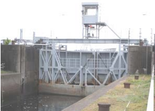
常時閉鎖。2つセットでパナマ運河方式で水位を買えて船を通す
