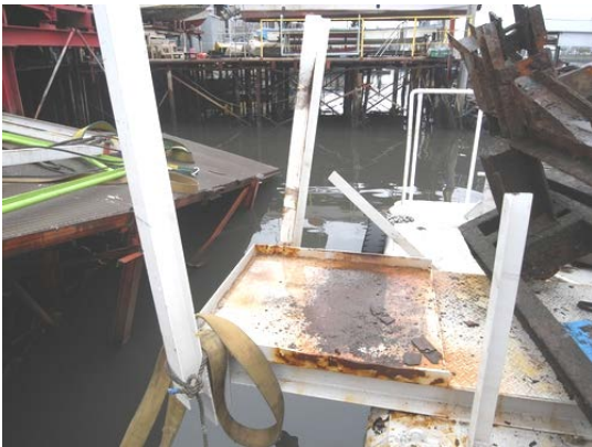
タラップが接続する桟橋部分。左右に90度振られたためにH鋼が大きく損傷
