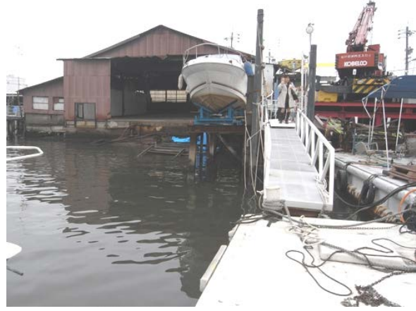
右の桟橋が底部損傷で水没。岸に寄せてある。本来はタラップの先に右奥の桟橋がある。
