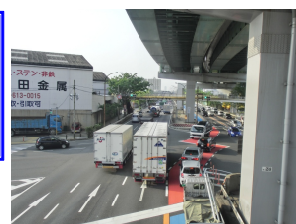
コンクリート片が右折のため交差点で停止中の車に落ちた現場
