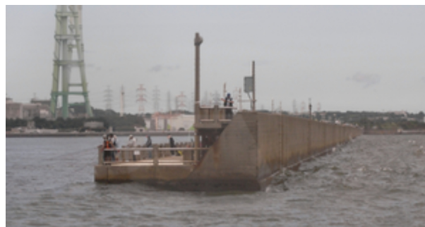
高潮防波堤 知多堤
