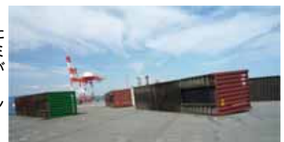
台風18号の被害を受けた三河港のコンテナターミナル。左が配置図、右が空荷で倒れたコンテナ。下が高潮で流されたコンテナ。
