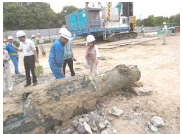
くい工事やり直しの現場
