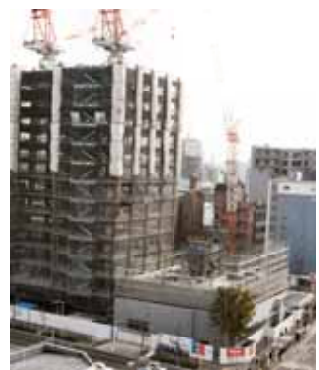
葵一丁目19番地区優良建築物整備事業 (ヤマザキマザックのニュータワー) 07~09
