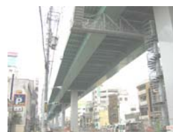
都市高速道路 (西区浄心)
