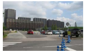
北側のマンション群。目の前が駐車場ビルになる計画です。
